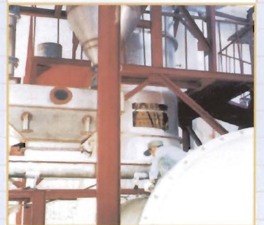
氧化镍煅烧施工现场
